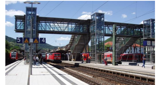
Abbildung 25: Barrierefreier Zugang zu den Gleisen
